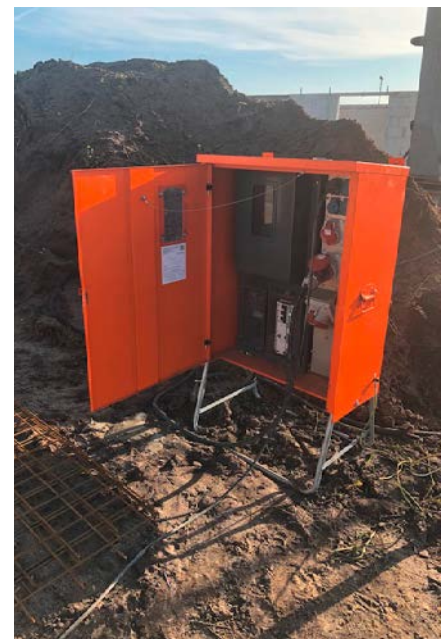
Baustromverteiler (bauseits zu stellen)
